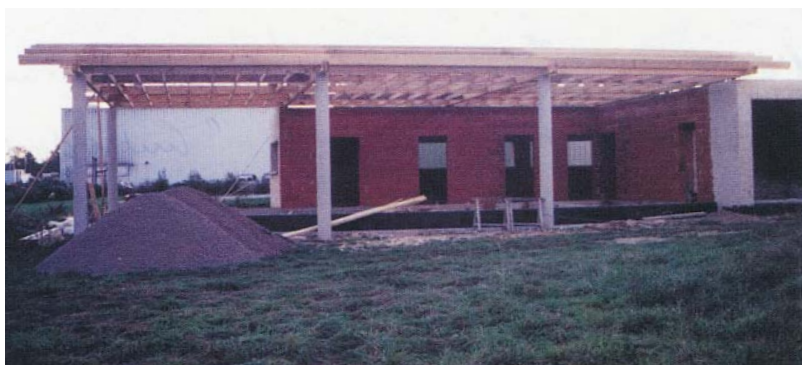
le laboratoire en chantier...
